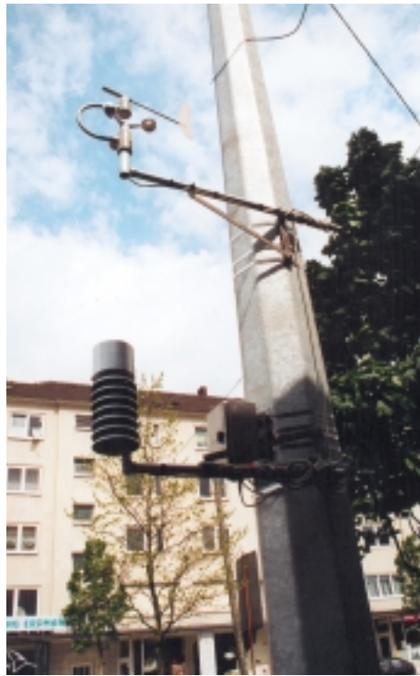
Detailansicht der Station Nordring. Unten sieht man den kombinierten Temperatur-Feuchtemessfühler und oben das Schalenkreuzanemometer und die Windfahne. In dem kleinen Kästchen befindet sich der Logger, in dem die Messdaten digital gespeichert werden.
